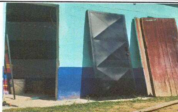
Foto 2: Puerta de baño
