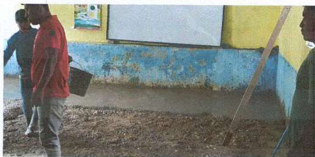
Foto 3: Reparacion de piso
