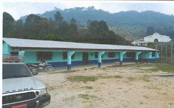
Foto 4: Canales y bajadas de agua pluvial
